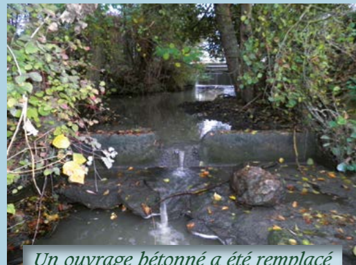
Un ouvrage bétonné a été remplacé par des blocs de pierres pour maintenir un débit minimum dans le bief en période sèche
