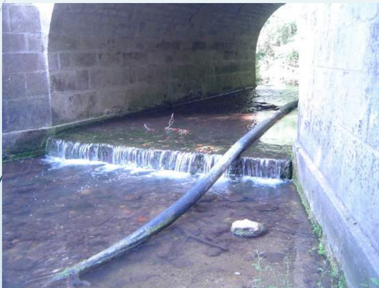
Seuil de pont au niveau du Ponceau à Crouzilles
