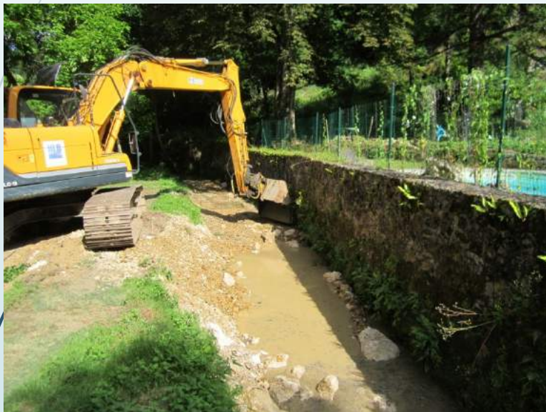
Travaux déjà réalisés sur le Courtineau (Malicorne - 2015)
