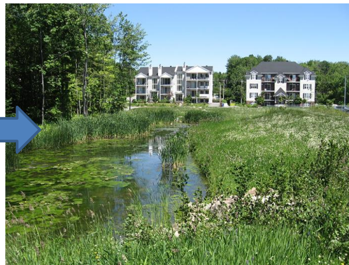
Bassin de rétention eaux pluviales
