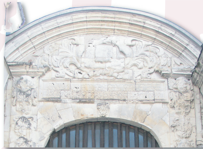
Détail de la porte sud des Halles - Detail of the southern door - Detalle de la puerta del sur © photothèque municipale - 2014
