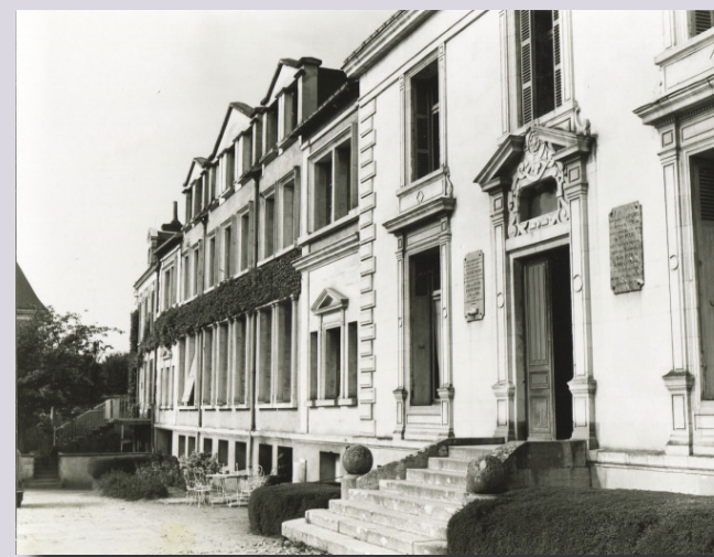
Photo de la façade dans les années 1960 - picture of the front of the hospital in the 1960's - fachada del hospital por los años 1960 Crédits : photo, vers 1960, archives de l'Hôpital
