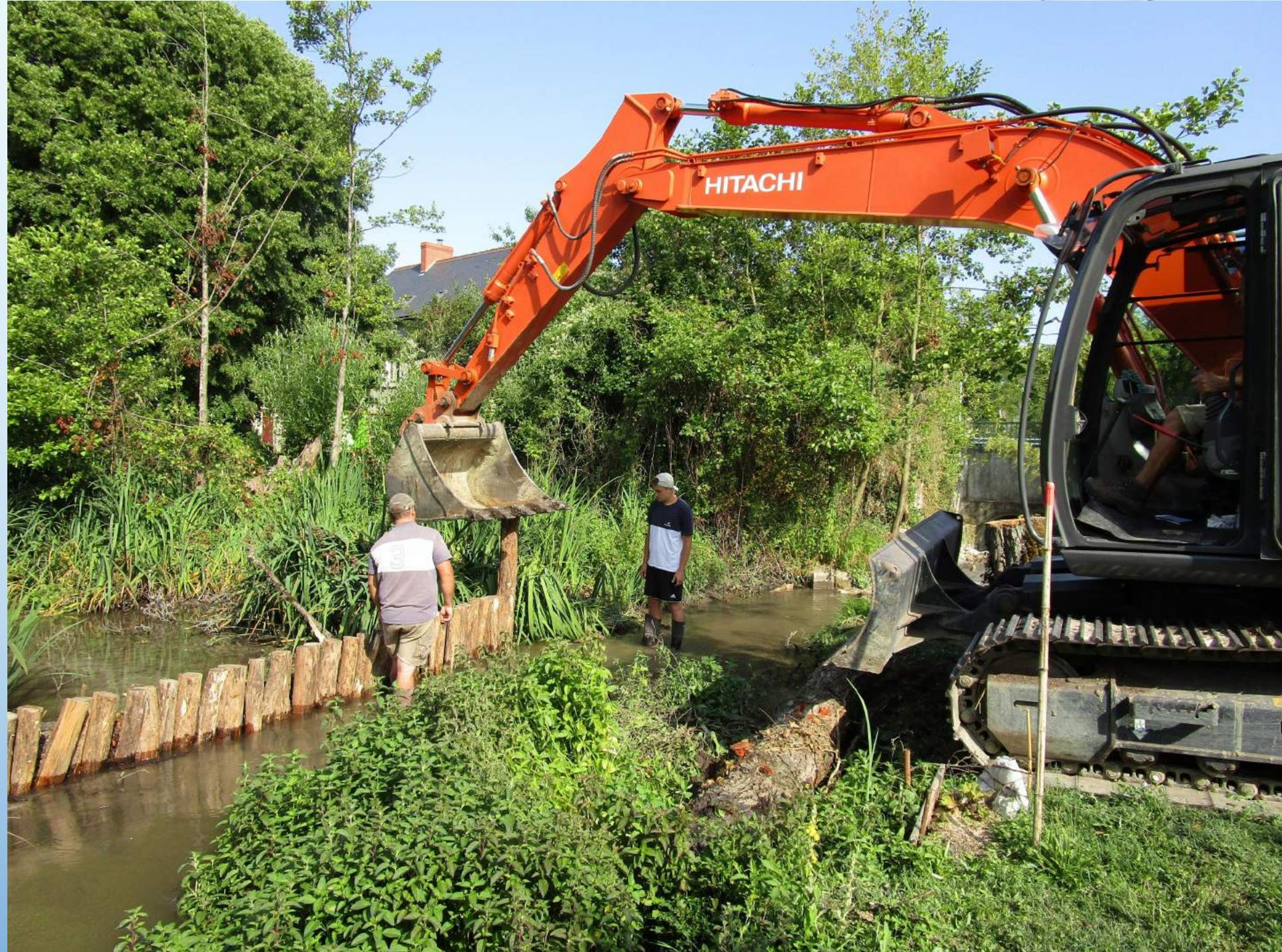
**La mise en place d'un cordon d'argile entre la digue de l'étang et le ruisseau**
