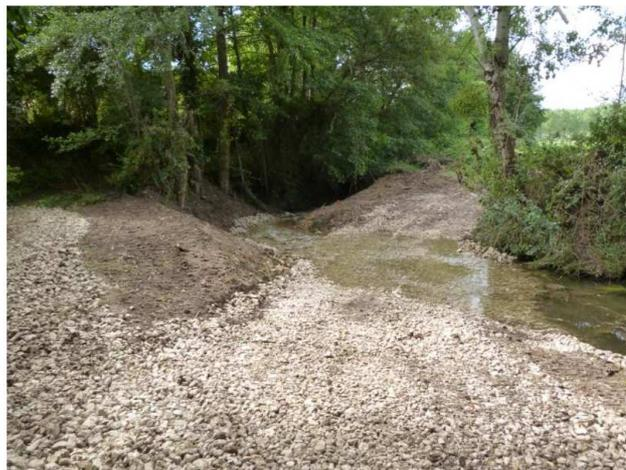
Un système de vannage était ici installé. Hors de fonctionnement et situé en zone de champs, sans aucun enjeux particulier, il a été décidé de le supprimer. Profitant de la présence du tractopelle, un passage à gué a été réaménagé par l'apport de blocs et de pierres.
