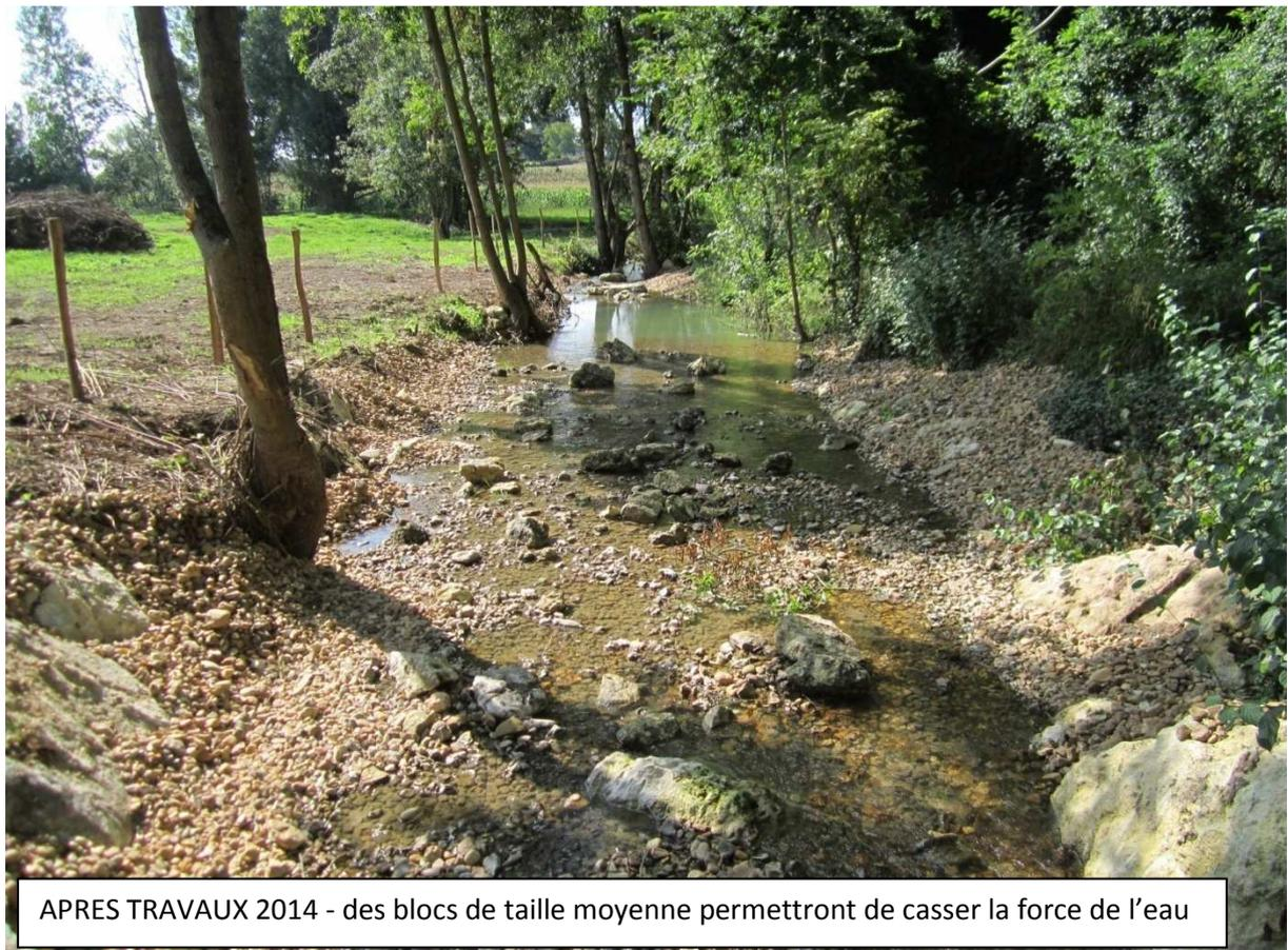
APRES TRAVAUX 2014 - des blocs de taille moyenne permettront de casser la force de l'eau
