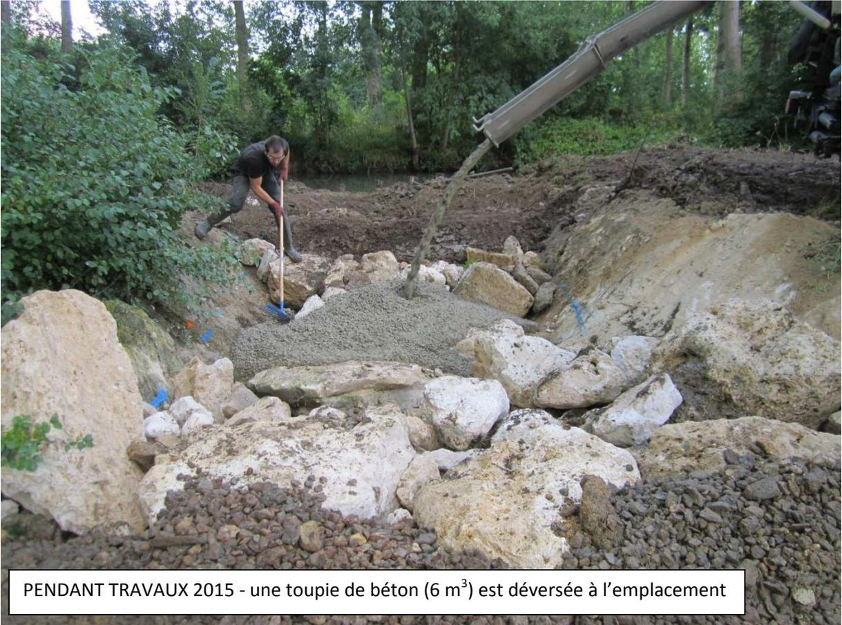
PENDANT TRAVAUX 2015 - une toupie de béton (6 m<sup>3</sup>) est déversée à l'emplacement
