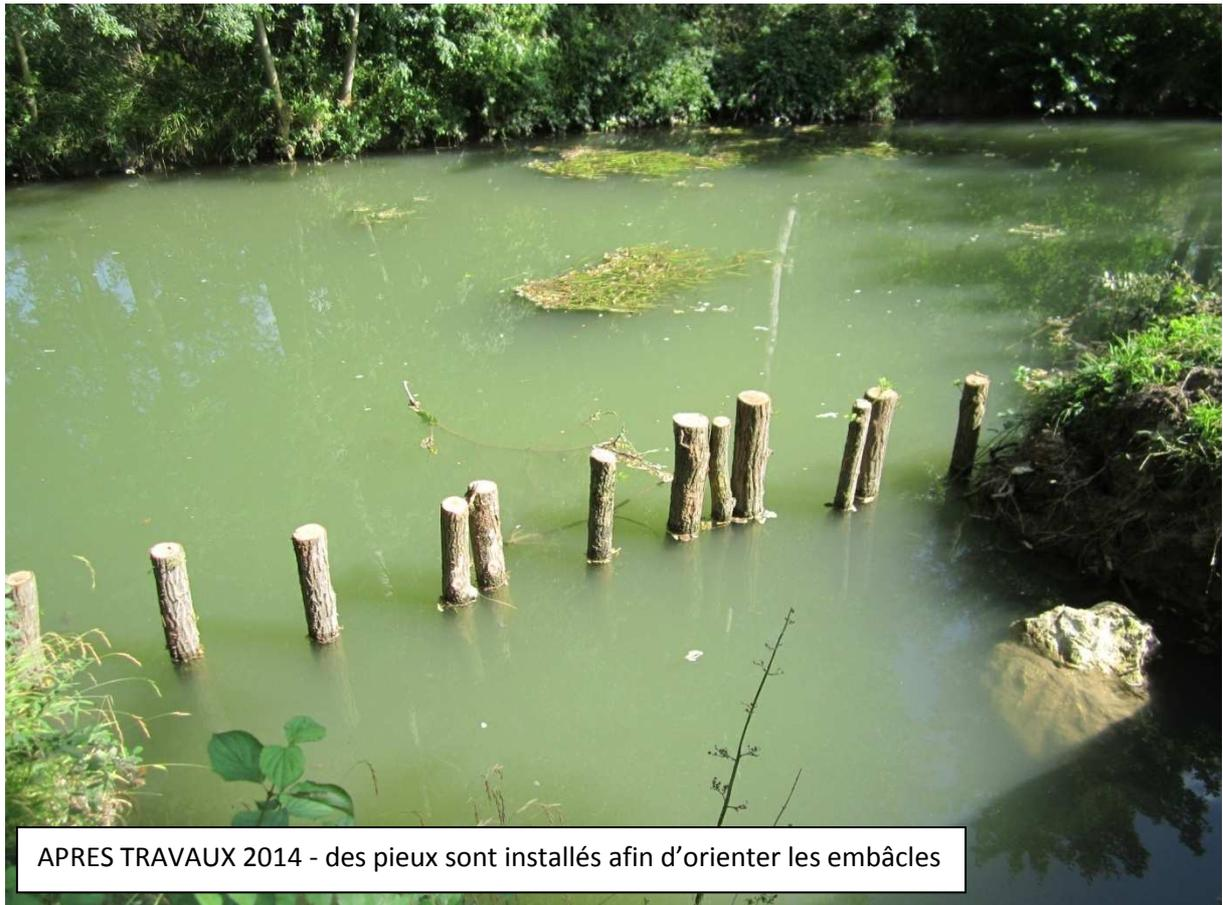
APRES TRAVAUX 2014 - des pieux sont installés afin d'orienter les embâcles
