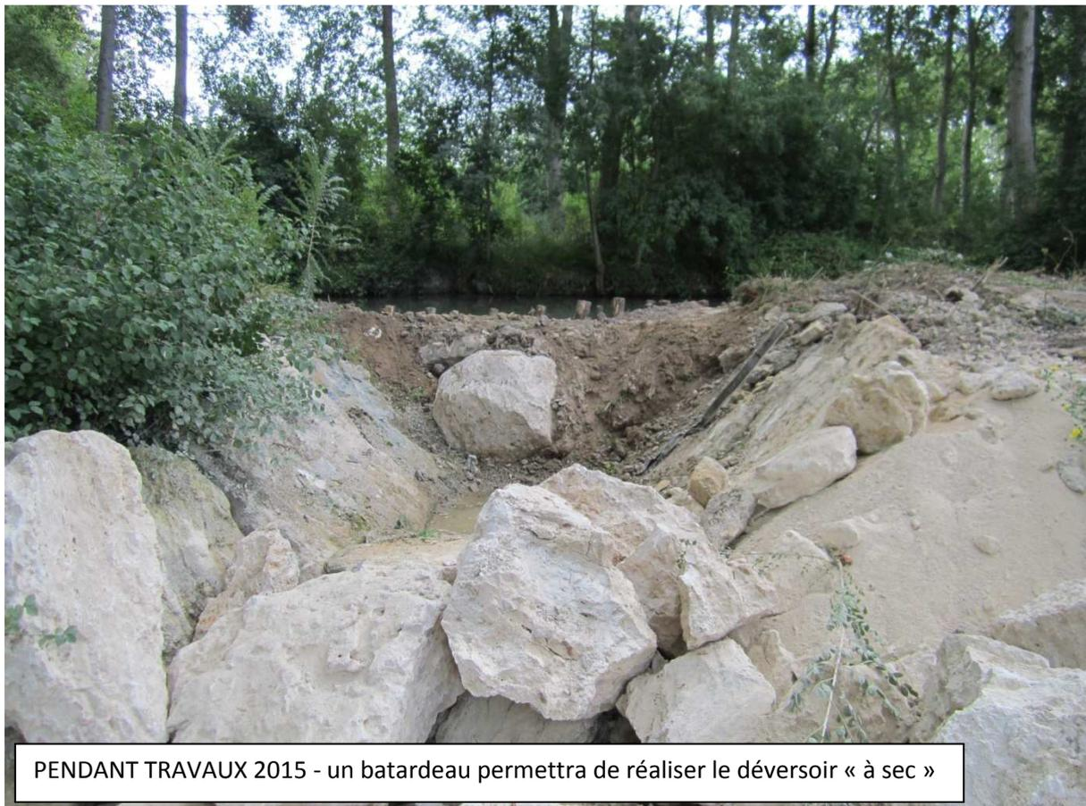
PENDANT TRAVAUX 2015 - un batardeau permettra de réaliser le déversoir « à sec »
