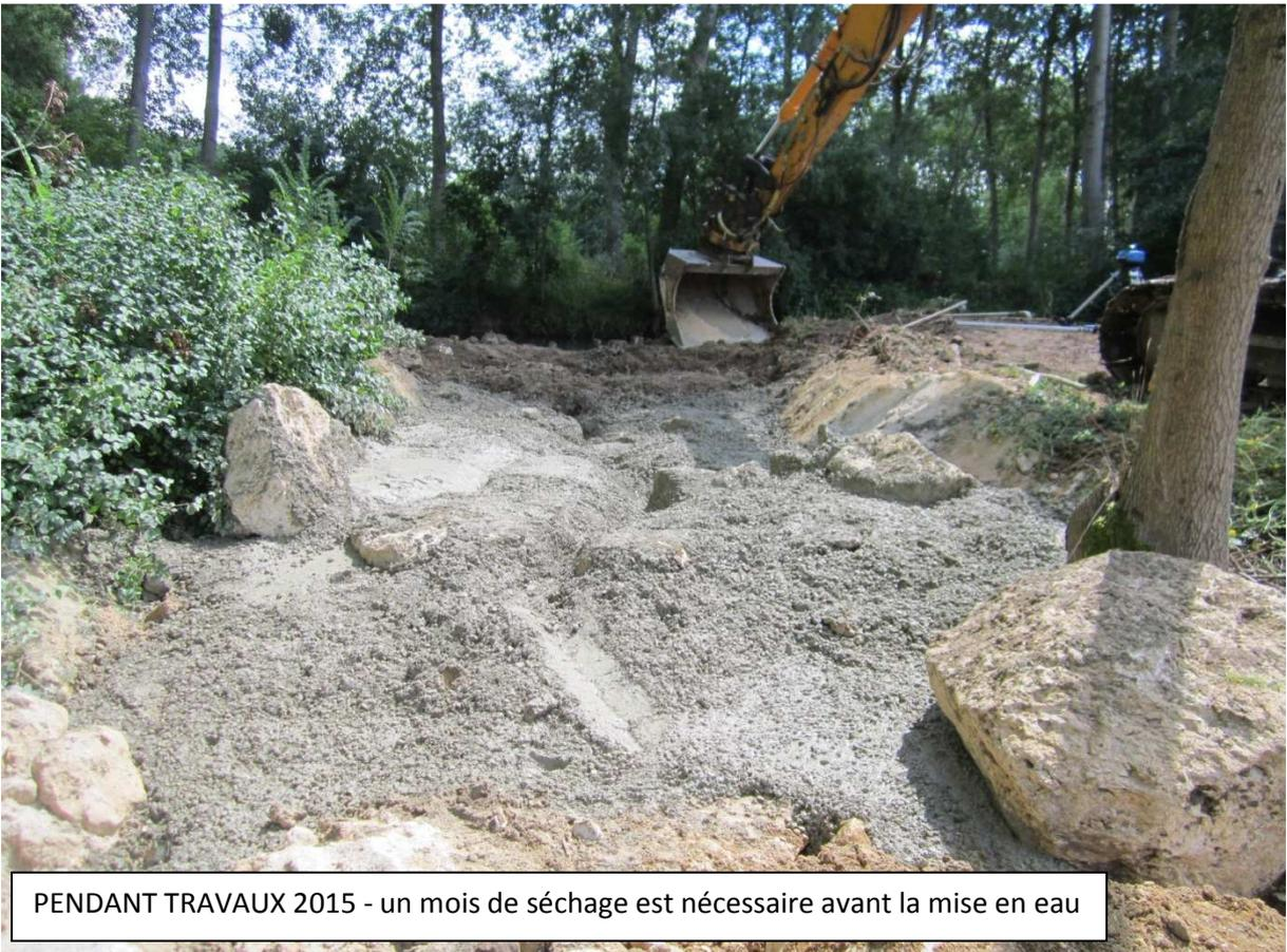
PENDANT TRAVAUX 2015 - un mois de séchage est nécessaire avant la mise en eau
