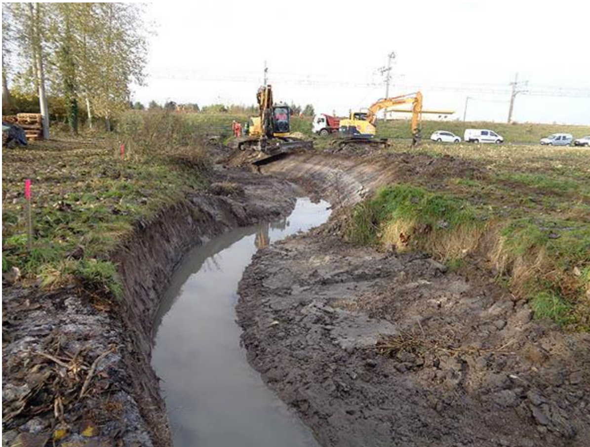
Travaux en cours sur le Réveillon (Maillé)
