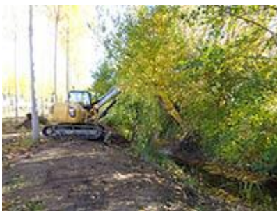
Travaux en cours sur le Ruau - adoucissement de berge
