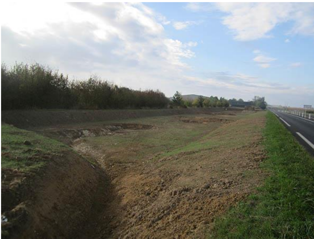
Vue de la zone tampon captant les eaux de ruissellement de 25 hectares via le réseau de fossé (en septembre - avant l'arrivée de l'eau)
