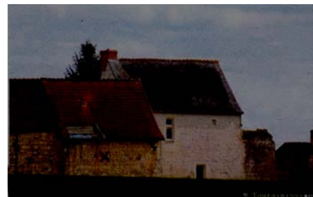
Vue plus récente de la face Nord
