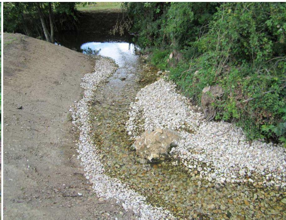
**La photo avant travaux (à gauche) montre l'état du seuil constitué d'anciens gros moellons. De par les travaux de réhaussement progressif du fond du lit sur 300 mètres de longueur, la chute d'eau s'est diminuée. Un empierrement massif permet une intégration des anciens blocs.**
