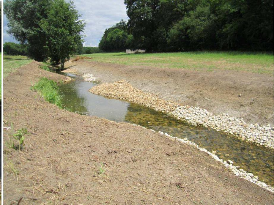
**Une seconde vue avant/juste après des travaux réalisés montre que la pose des granulats\*\*\* redonne des formes latérale au cours d'eau. Un cours d'eau rectiligne procure moins d'habitats et d'oxygénation qu'un cours d'eau méandriforme.**
