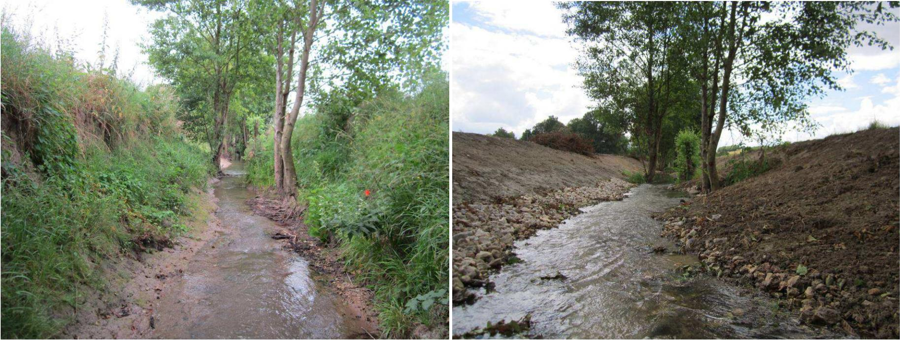
**Une première vue avant/juste après des travaux réalisés. On observe que le fond du lit a été réhaussé par l'apport de blocs et de pierres. Puis les berges ont été talutées en pente plus douce pour leur meilleur maintien (en complément, un ensemencement permet de fixer la terre).**
